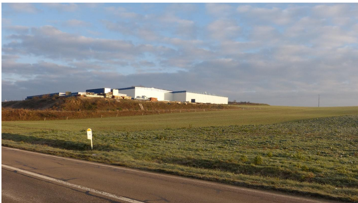
L'entreprise BERGELIN vue depuis la RD 67, photographie prise le 29.11.2023
