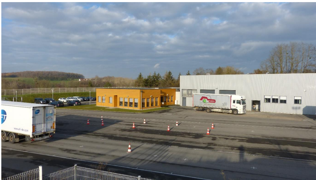
Les installations du lycée Fertet, photographie prise le 29.11.2023
